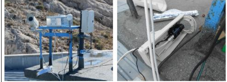
Şekil 1 – TUG Bakırlitepe Yerleşkesi, "TUG 1" kamerası (a) Genel görünüm (b) kamera muhafazası iç görünümü (Enlem: 36.824166° Kuzey; Boylam: 30.335555°; Rakım: 2500m)
